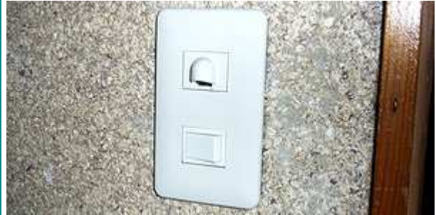
LED2個、AC100V用の足元灯 電力極小 スイッチの位置を示すホタル表示と兼用
